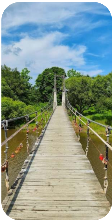
Подвесной мост через протоку Драгучина
